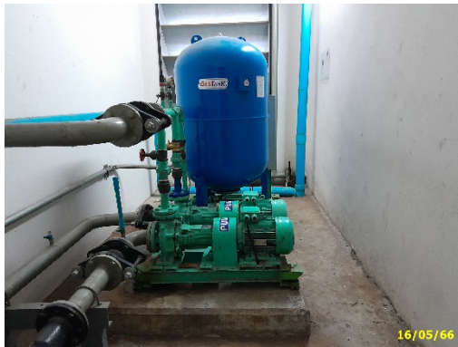
Booster Pump ชั้นดาดฟ้า
